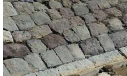
「高輪築堤」海側の傾斜した石積み
