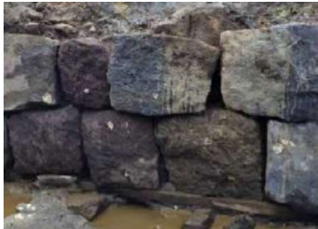
「高輪築堤」山側の垂直の石積み
