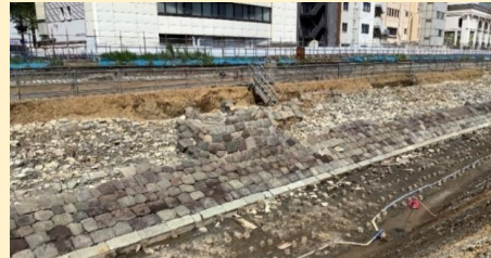
信号機土上部の様子
