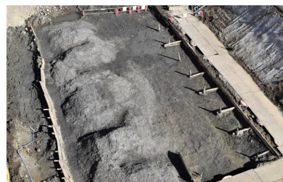
マウンド状に盛土を連ねた築堤の芯(1街区)
