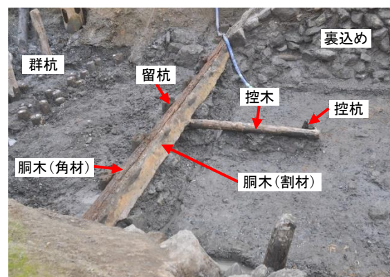
石垣土台部の木組基礎(第2東西道路部分)
