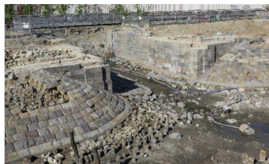
▲史跡指定地(第7橋梁部)
