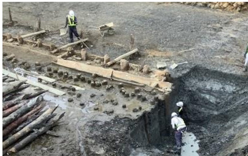
⑦ナンバリングした杭を1本ずつ引き抜き計測
