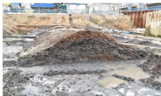
蒲鋒形に盛土された築堤の芯(1街区)
