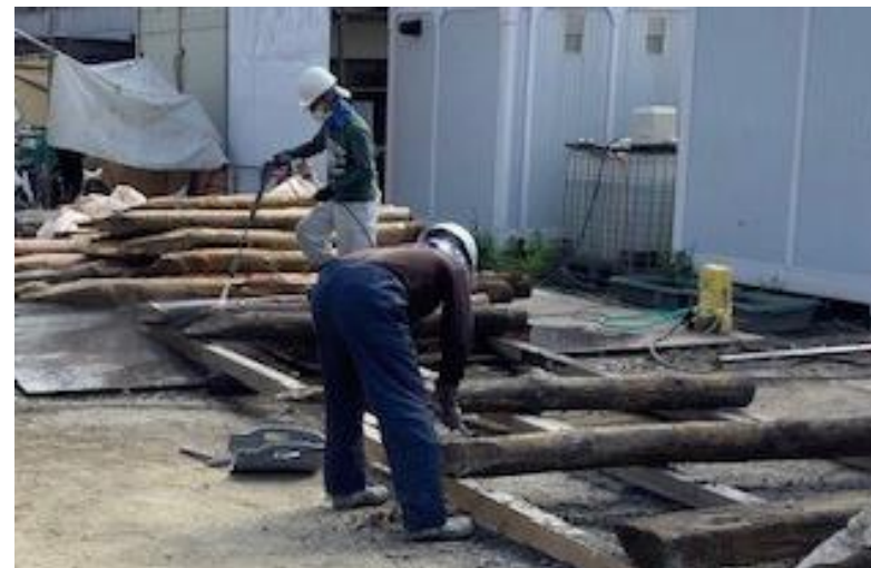
⑦ナンバリングした杭を1本ずつ引き抜き計測
