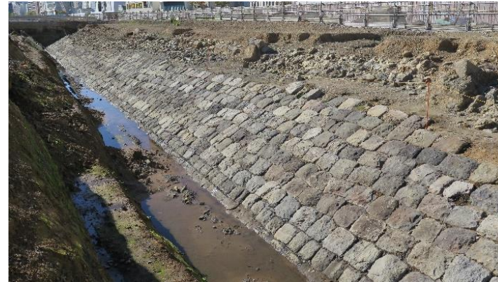
公園部の築堤
