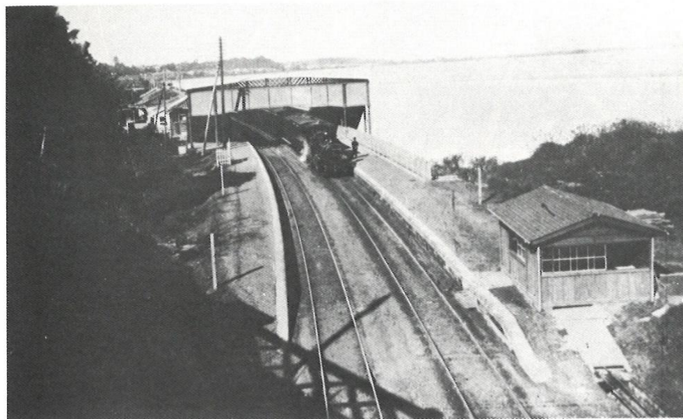
その後の写真。ホームは延伸され、跨線橋も出来ている。右手前の小屋は信号梃子扱所か
