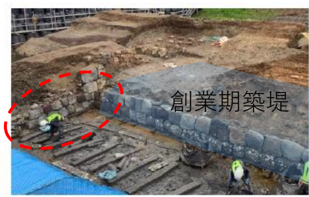
写真①：北横仕切堤石垣
