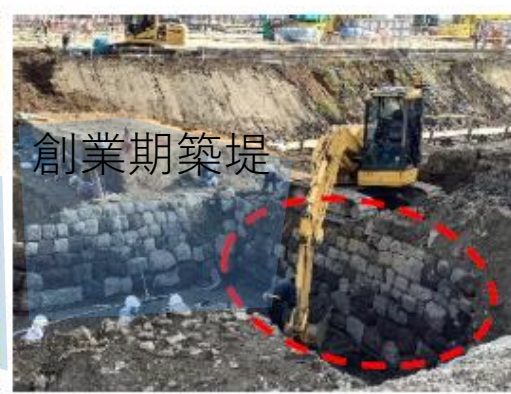
写真②：南横仕切堤石垣
