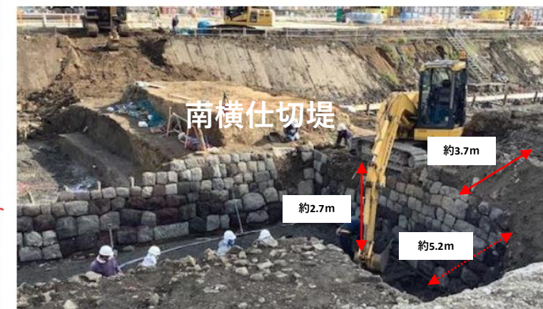
写真③ 南横仕切堤 北側
