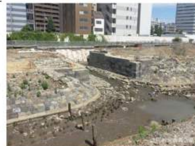
史跡となる第7橋梁の橋台部分(国指定史跡)
