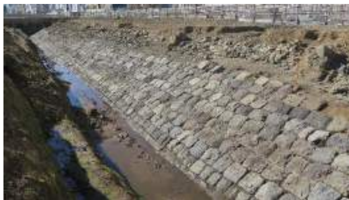
公園部の築堤
