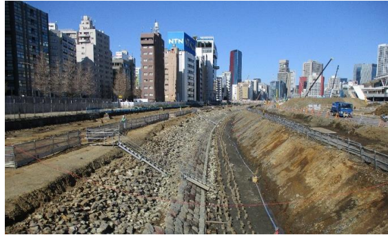
② 4街区の高輪築堤跡の景観（南から）
