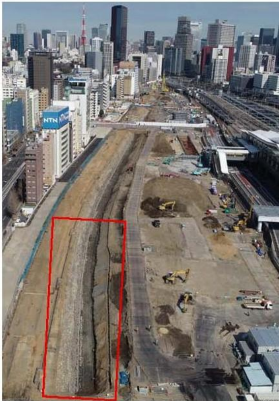
③ 4街区の高輪築堤跡の景観（空中写真・南から）
