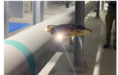
ドローンを活用した設備点検
