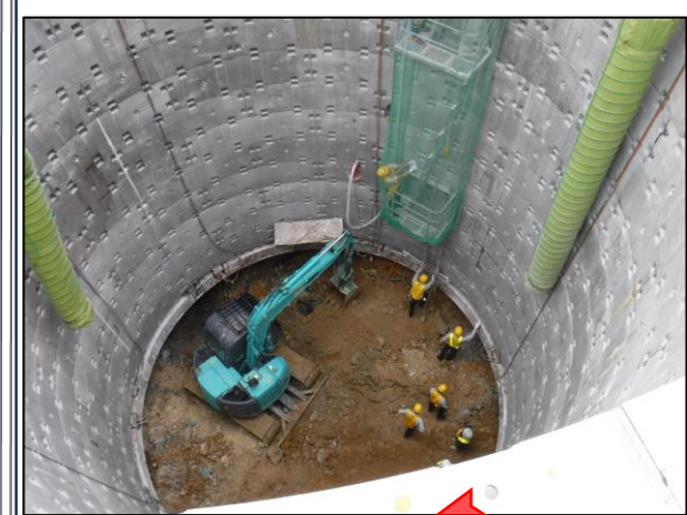
杭（深礎工法）写真
