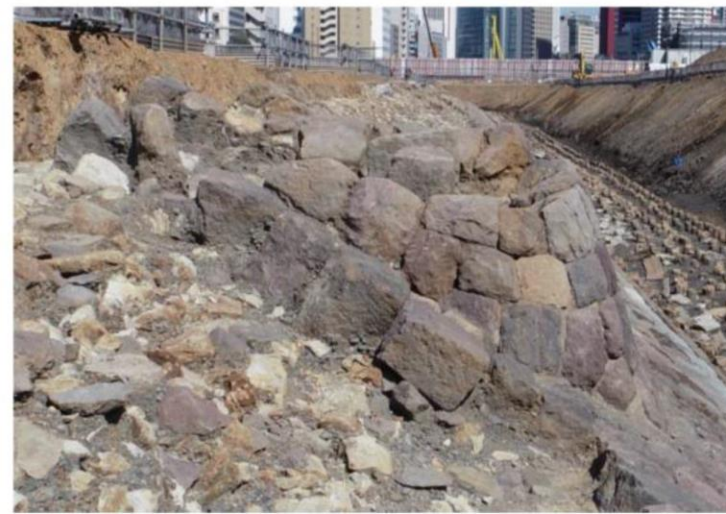
4街区信号機土台部 南側側面
