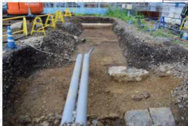
トレンチ⑦ 築堤盛土確認面(東から)
