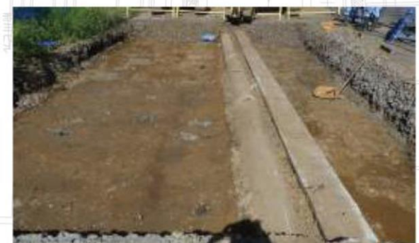
トレンチ⑧ 築堤盛土確認面(南から)
