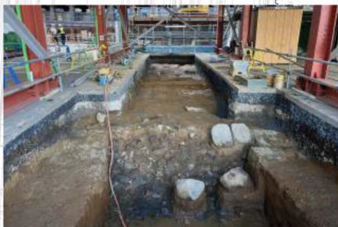
トレンチ⑤ 開業期海側石垣(東から)
