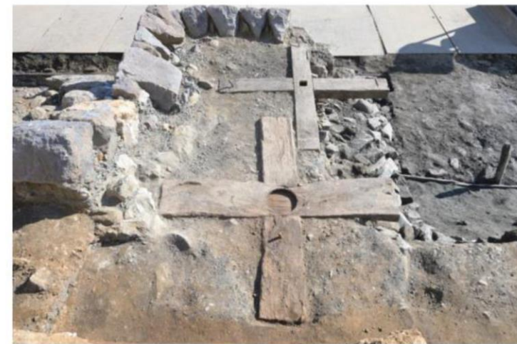
4街区信号機土台部 角材十字基礎
