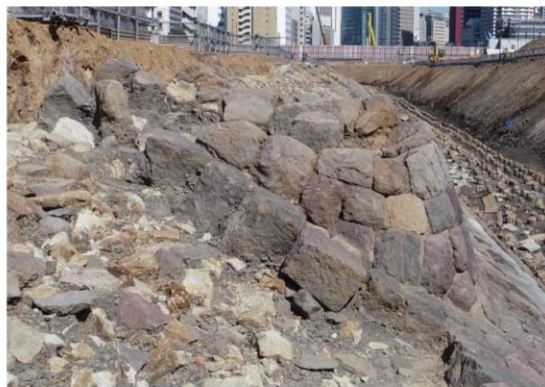
4街区信号機土台部 南側側面
