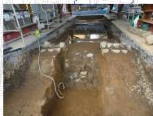
開業期海側裏入れ石(東から)
