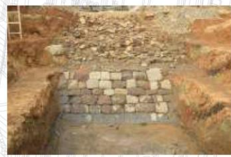
開業期海側石垣(東から)
