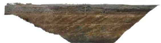
トレンチ① 北壁断面
