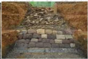
開業期海側石垣(東から)
