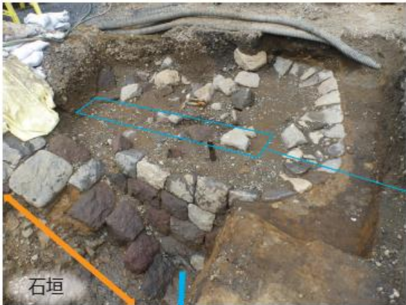
←開業期海側石垣と張り出し遺構検出状況（南東から撮影）
