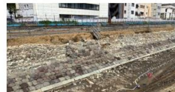
信号機土台の様子
