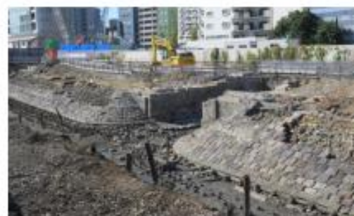
現在の橋梁部の様子
