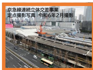
京急線連続立体交差事業 定点撮影写真 令和6年2月撮影 出典:東京都建設局 京浜急行本線(泉岳寺駅～新馬場駅間)連続立体交差事業
