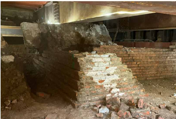
レンガ基礎検出状況 上：2026.6.17 撮影 下：2026.7.29 撮影
