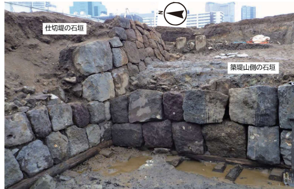
第7橋梁北横仕切堤（2街区）
