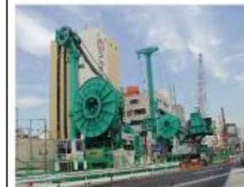
RC連壁 施工状況
