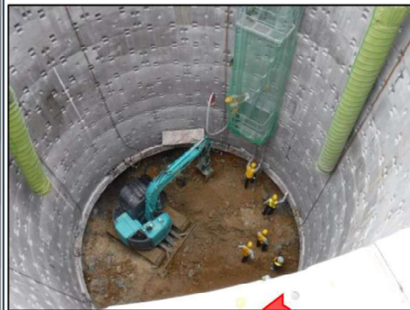
杭（深礎工法）写真
