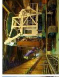
RC連壁 施工状況 路下鋼製連壁 施工状況
