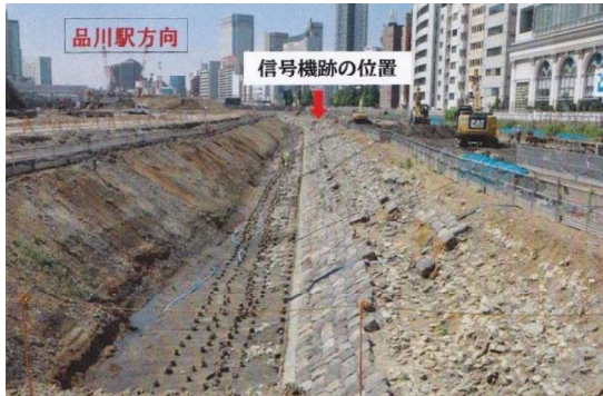
① 4街区の高輪築堤跡の景観（北から）
