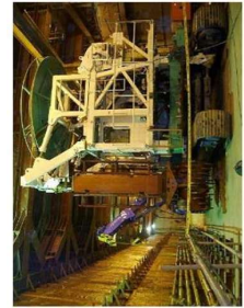
RC連壁 施工状況 路下鋼製連壁 施工状況 出典:安藤ハザマHP 本澤設立技術師 適用例 / URL:https://www.adhzm.co.jp/solution/s.tunnel/detail.16/
