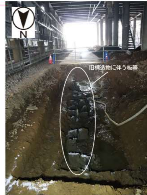
◀ ピット下構造物確認状況 (2022年8月3日撮影)
