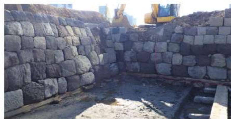
▲ 第7橋梁南横仕切堤 (2021年11月17日撮影)
