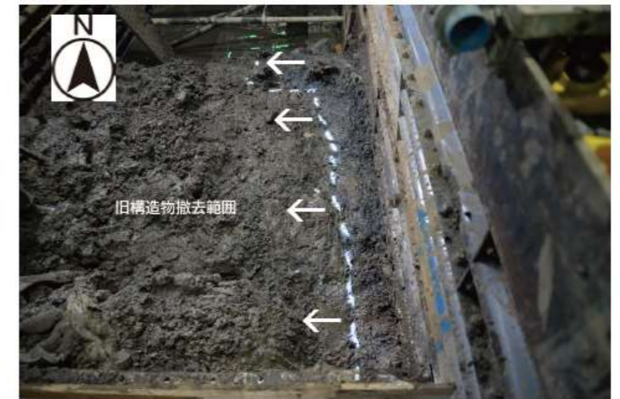
▲ 構造物撤去時掘削範囲確認状況 (2025年6月16日撮影)
