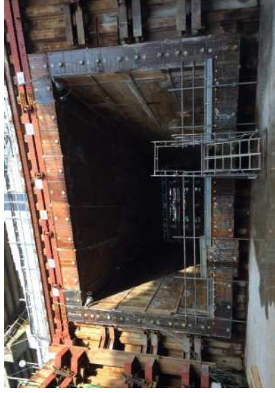
※非開削構造物の例 線路下をHEP&JES工法で施工した場合
