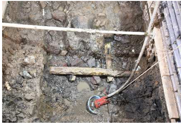
②北側裏込め、胴木等検出状況 (2025年2月26日撮影)
