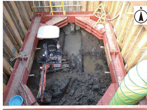
①土留め列 A 検出状況（南から）2023.9.27
