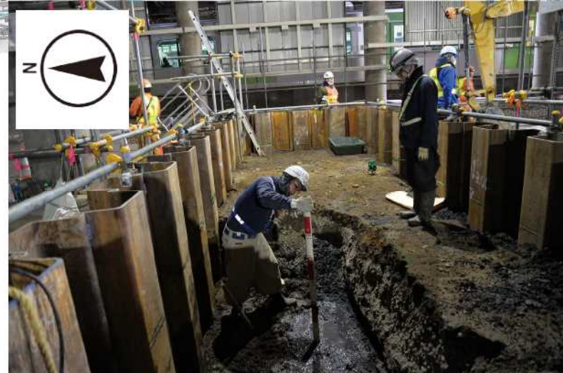
トレンチ調査状況 (西から)
