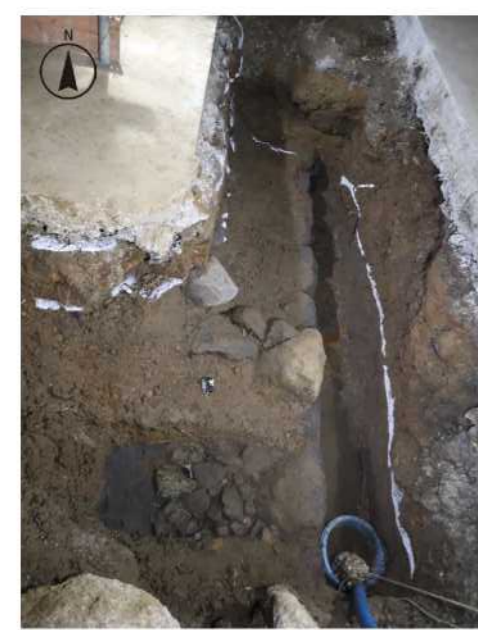
①石積検出状況（2023.7.24）
