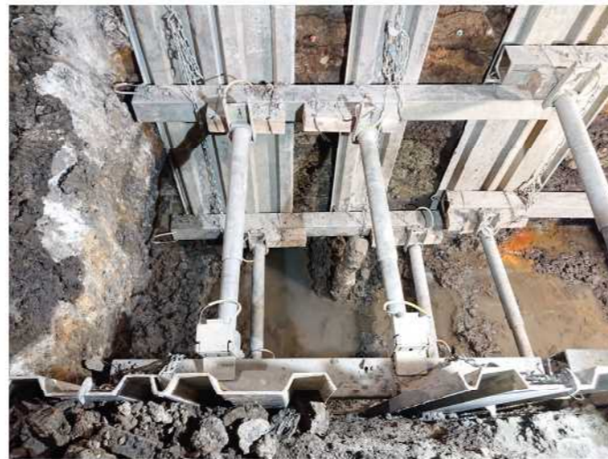
①杭出土状況(2023.2.10)
