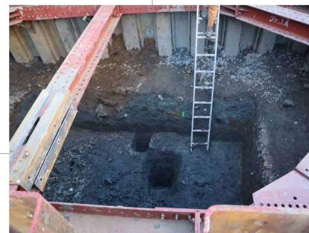
写真① 硬質粘土層確認状況
