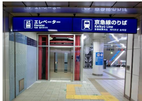
エレベーター更新 （羽田空港国内線ターミナル駅）
