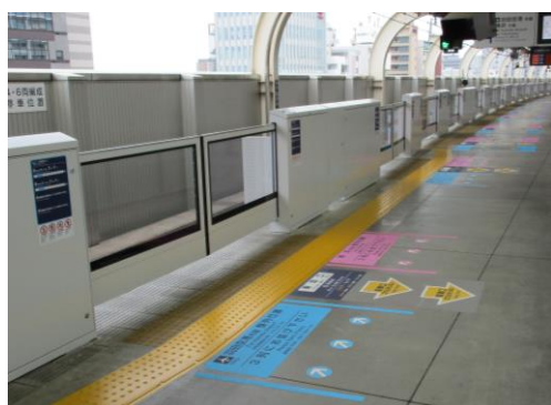
ホームドア設置（京急蒲田駅）
