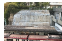
追浜駅構内法面防護工事
