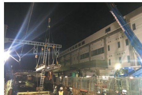
東門前駅付近の仮橋の撤去
