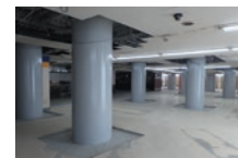
平和島駅構内高架橋
