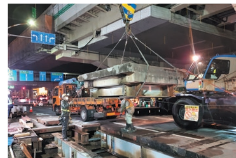
産業道路部分の踏切版の撤去
