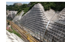
法面防護工事
