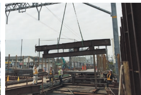
大師橋駅付近地上仮設設備の撤去
