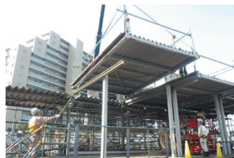
大師橋駅地上仮設ホーム上家撤去
