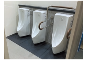
北久里浜駅旅客用トイレ改修
