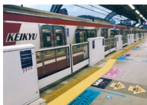
京急蒲田駅に設置しているホームドア
