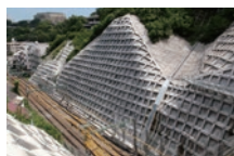
法面防護工事
