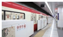
羽田空港国内線ターミナル駅に設置しているホームドア
