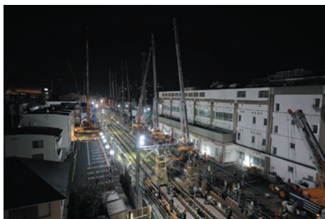
クレーンによる切替え作業
