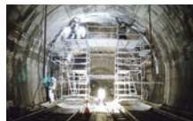
トンネルの補修工事の様子
