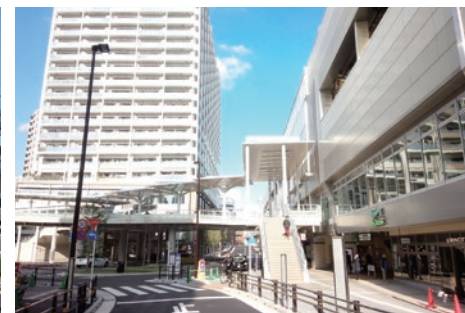
京急蒲田駅 西口側
