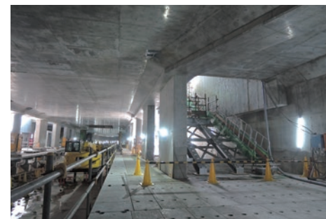
産業道路駅付近での躯体構築状況
