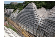
法面防護工事
