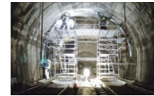
トンネルの補修工事の様子
