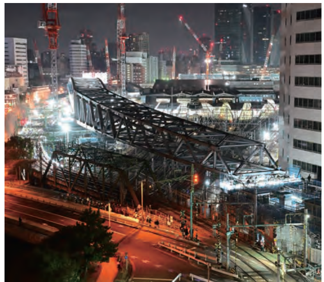
▲八ツ山跨線々路橋の架設状況
