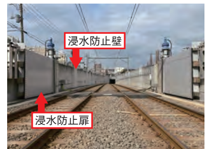
▲大師橋駅地上出入口(小島新田方)
