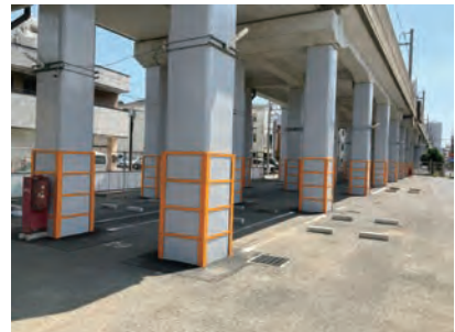
▲弘明寺～上大岡駅間耐震補強完了後
