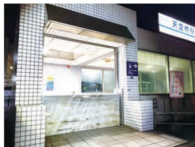
▲天空橋駅防水シート
