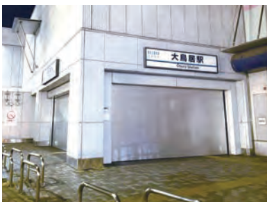
▲大鳥居駅防水シャッター
