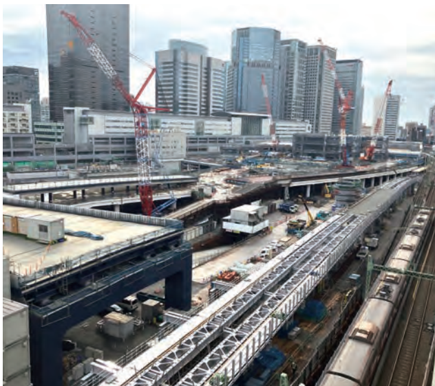
▲仮線高架橋の構築状況
