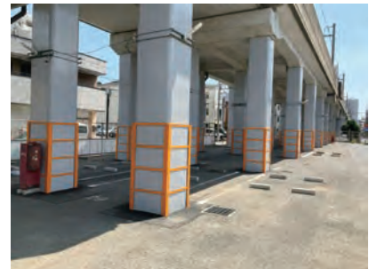
▲弘明寺～上大岡駅間耐震補強完了後
