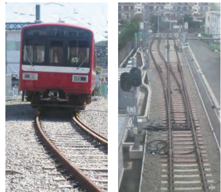
▲カント(傾斜)をつけた脱線復旧訓練線(左) 教育訓練線(右)
