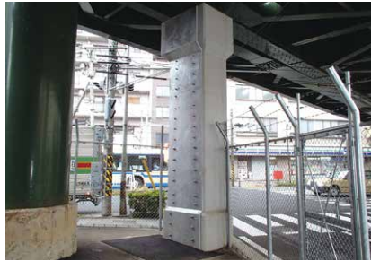
▲施工完了 日ノ出町～黄金町駅間
