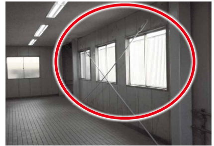
▲穴守稲荷駅 跨線橋部
