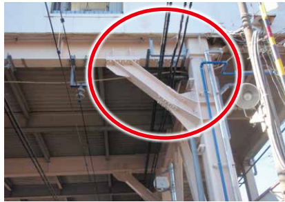
▲穴守稲荷駅 下りホーム側
