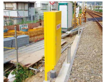
▲ 各駅や駅間に設置した非常脱出ハシゴ
