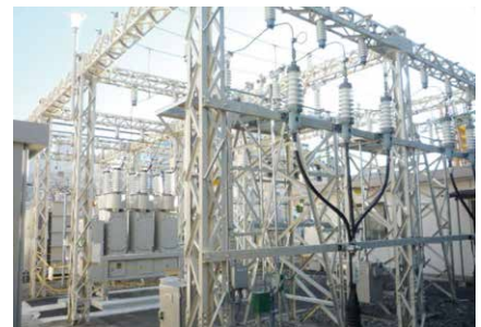
▲川崎変電所 受電設備
