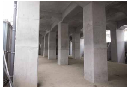
▲施工完了 黄金町～南太田駅間
