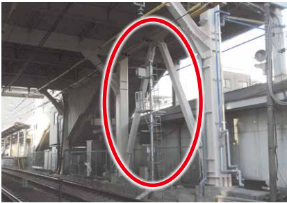
▲穴守稲荷駅 下りホーム側
