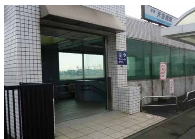
▲天空橋駅地上入口
