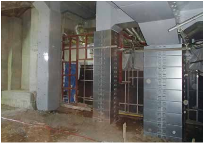
▲施工中 日ノ出町駅
