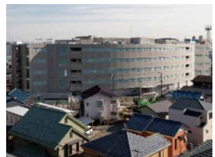
▲金沢文庫現業事務所 外観
