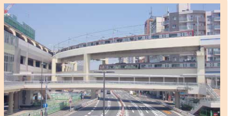
▲上下線が立体化された箱根駅伝で有名な国道15号踏切跡
