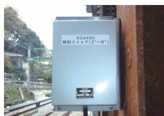
▲落石検知装置
