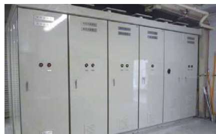
▲川崎変電所 交流高圧配電設備
