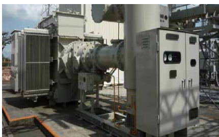
▲南太田変電所 66kVガス絶縁開閉装置
