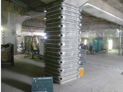
▲上大岡駅構内高架橋
