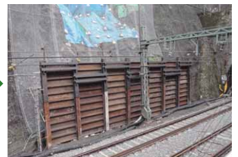
▲強化後(鋼鉄製・高さ5m)
