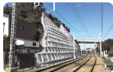
地震対策として、高架橋柱の耐震補強工事については、2019年度は平和島駅構内、弘明寺～上大岡駅間を施工しました。2020年度以降は新馬場駅構内、引き続き、平和島駅構内の高架橋柱の工事を進めてまいります。法面防護工事は、横須賀中央～県立大学駅間上り線側および安針塚～逸見駅間上り線側にて工事を完了し、追浜駅構内上り線側で工事を進めています。また、気象庁の発表する緊急地震速報を利用し、当社線に被害が予測される場合に、全列車の運転台に警音を送信することにより、運転士が列車を安全と思われる場所に緊急停止させる「緊急地震速報システム」を2006年8月に設置し、稼働させています。
