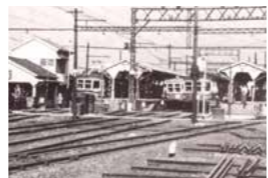
新設した待避設備(学校裏駅)
