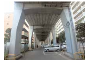
鮫洲～立会川駅間
