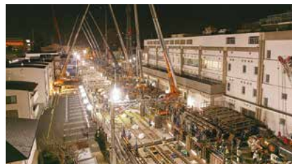
クレーンによる切替え作業
