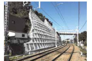
馬堀海岸～浦賀駅間 上り線側(施工後)
