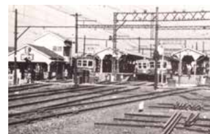
新設した待避設備(学校裏駅)
