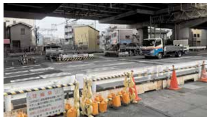
産業道路第1踏切道除却後
