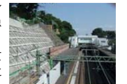
弘明寺駅構内
