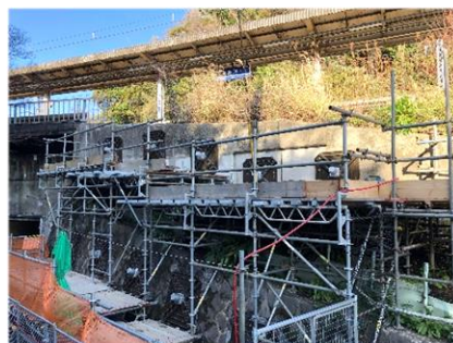
<浦賀駅構内法面防護工事>
