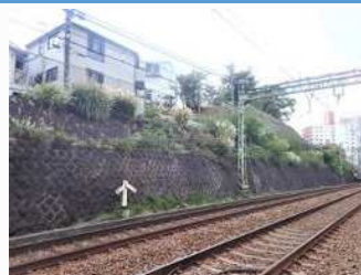
神奈川駅付近石積擁壁耐震補強
