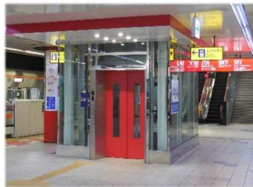
< エレベーター更新例（羽田空港第1・第2ターミナル駅） >
