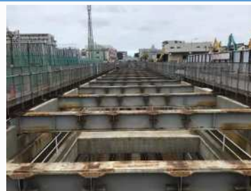
工事桁撤去後の状況
