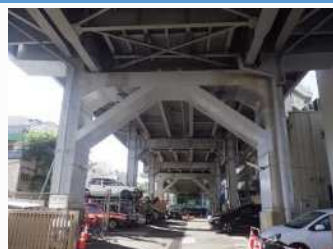
新馬場駅構内高架橋耐震補強
