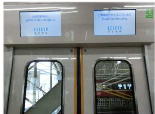
<車内案内表示器の更新例>
