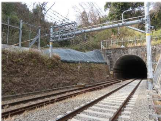
<六浦～神武寺駅間法面防護工事>
