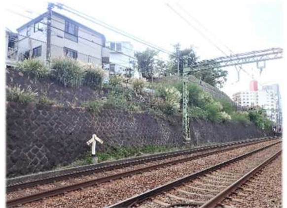
<神奈川駅付近石積擁壁補強工事>
