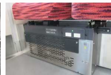
コンセントの設置
