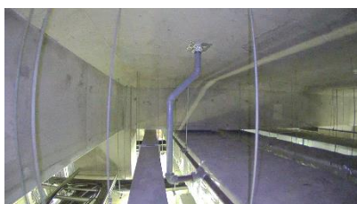
狭小空間特化型ドローン「IBIS（アイビス）」で撮影した天井裏の画像
