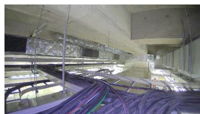
狭小空間特化型ドローン「IBIS（アイビス）」で撮影した天井裏の画像
