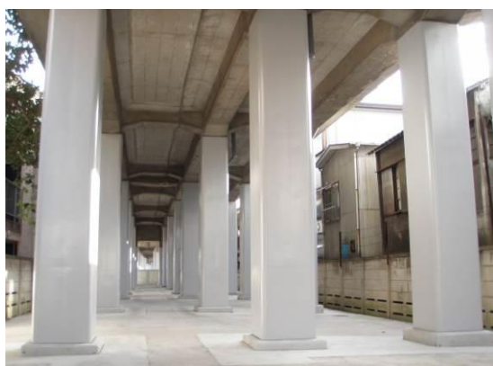
高架橋耐震補強（大森海岸～平和島）
