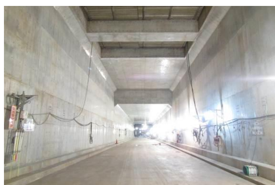
大師線連続立体交差事業（第1期）
