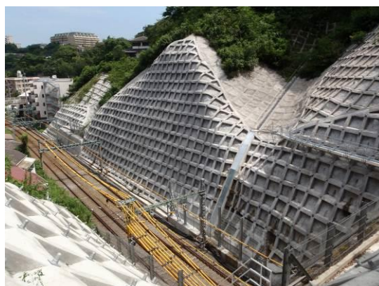
法面防護（追浜～京急田浦）
