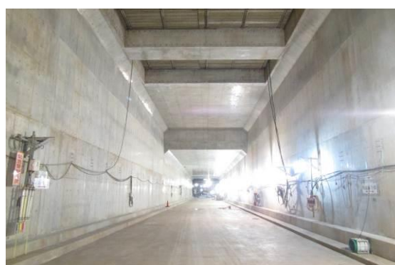
大師線連続立体交差事業（第1期）
