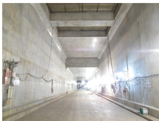
大師線連続立体交差事業（第1期）
