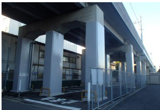
高架橋耐震補強（新馬場～青物横丁）
