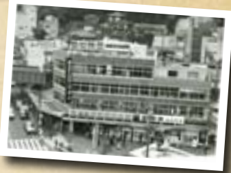
1979(昭和54)年当時。4階建ての駅舎はその後、大幅な改修工事が繰り返されたが、原型はそのまま。
