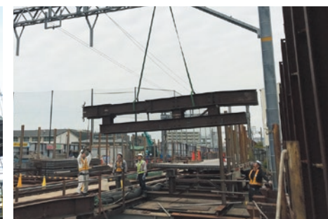
大師橋駅付近地上仮設設備の撤去
