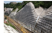
法面防護工事
