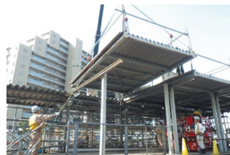
大師橋駅地上仮設ホーム上家撤去
