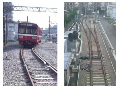
▲左:カント(傾斜)をつけた脱線復旧訓練線 右:教育訓練線
