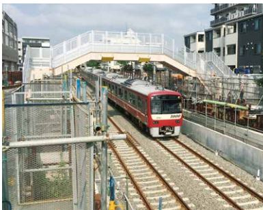
▲ 跨線人道橋整備状況
