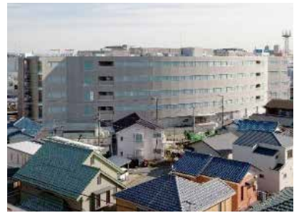
▲金沢文庫現業事務所 外観
