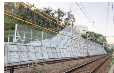
▲横須賀中央～県立大学駅間 上り線側(施工後)
