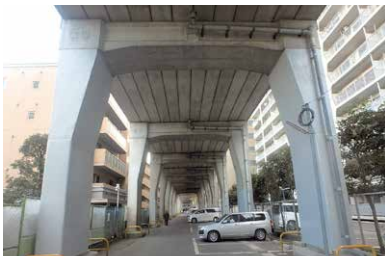
▲鮫洲～立会川駅間
