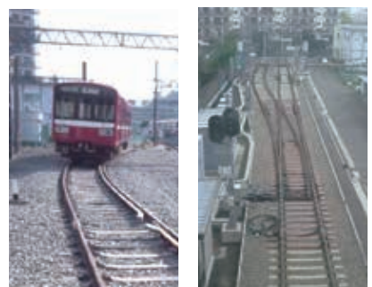
▲左:カント(傾斜)をつけた脱線復旧訓練線 右:教育訓練線
