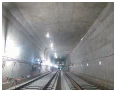
▲東門前～産業道路駅間の工事状況②
