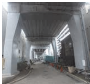
▲鮫洲～立会川駅間
