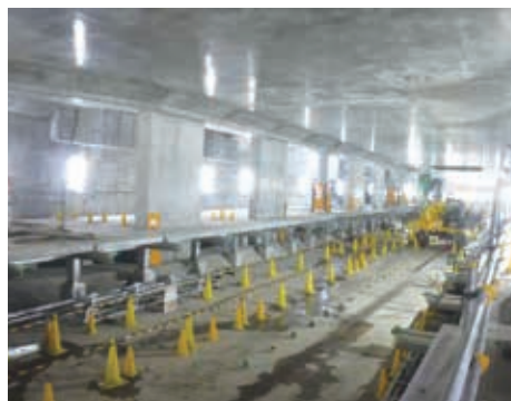
▲産業道路駅の工事状況
