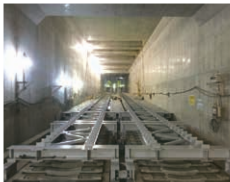
▲東門前～産業道路駅間の工事状況①
