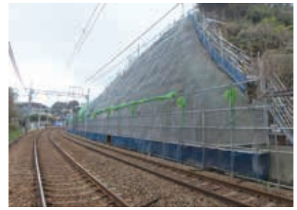
▲馬堀海岸～浦賀駅間 上り線側(工事中)
