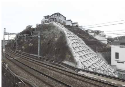
▲杉田～京急富岡駅間 上り線側
