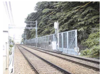
▲県立大学～堀ノ内駅間
