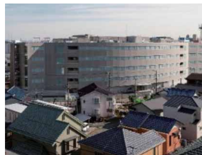
▲金沢文庫現業事務所 外観
