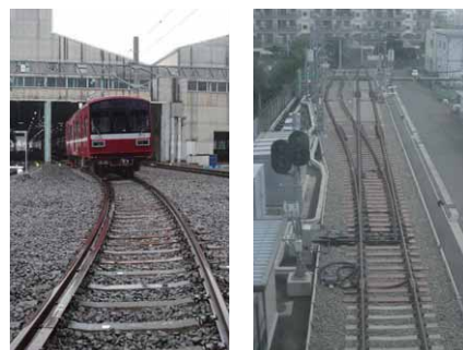
▲左:カント(傾斜)をつけた脱線復旧訓練線 右:金沢文庫駅構内 教育訓練線
