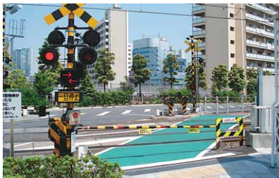
▲警報機・遮断機
