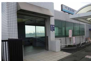
▲天空橋駅地上入口
