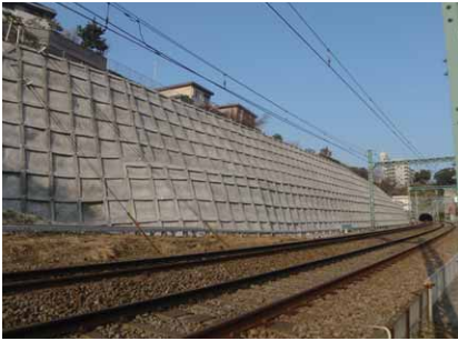
▲南太田～井土ヶ谷駅間 上り線側
